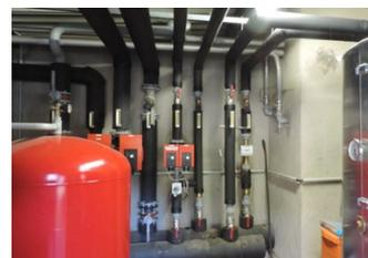
Le toit de 1100 m<sup>2</sup> a été complètement refait avec des plaques aluminium grises. Après la mise en place du réseau chaleur bois dans ces salles, à la piscine et au gymnase l'ensemble des pompes et réglages est installé dans l'ancienne chaufferie du gymnase.
